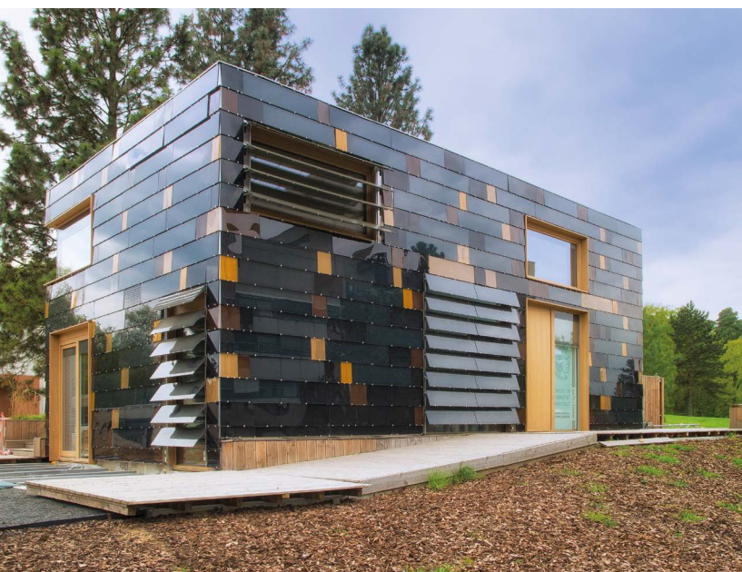
Energieautarkes Gebäude mit Phasenwechselmaterialien in der Fassade, entwickelt für den „Solar Decathlon“ Wettbewerb
